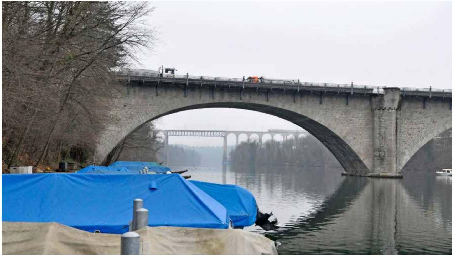
Neben der Strassenbrücke im Vordergrund und der Eisenbahnbrücke im Hintergrund soll ein weiterer Übergang für Entlastung des Verkehrs in Eglisau sorgen. ARCHIVBILD M. G.
