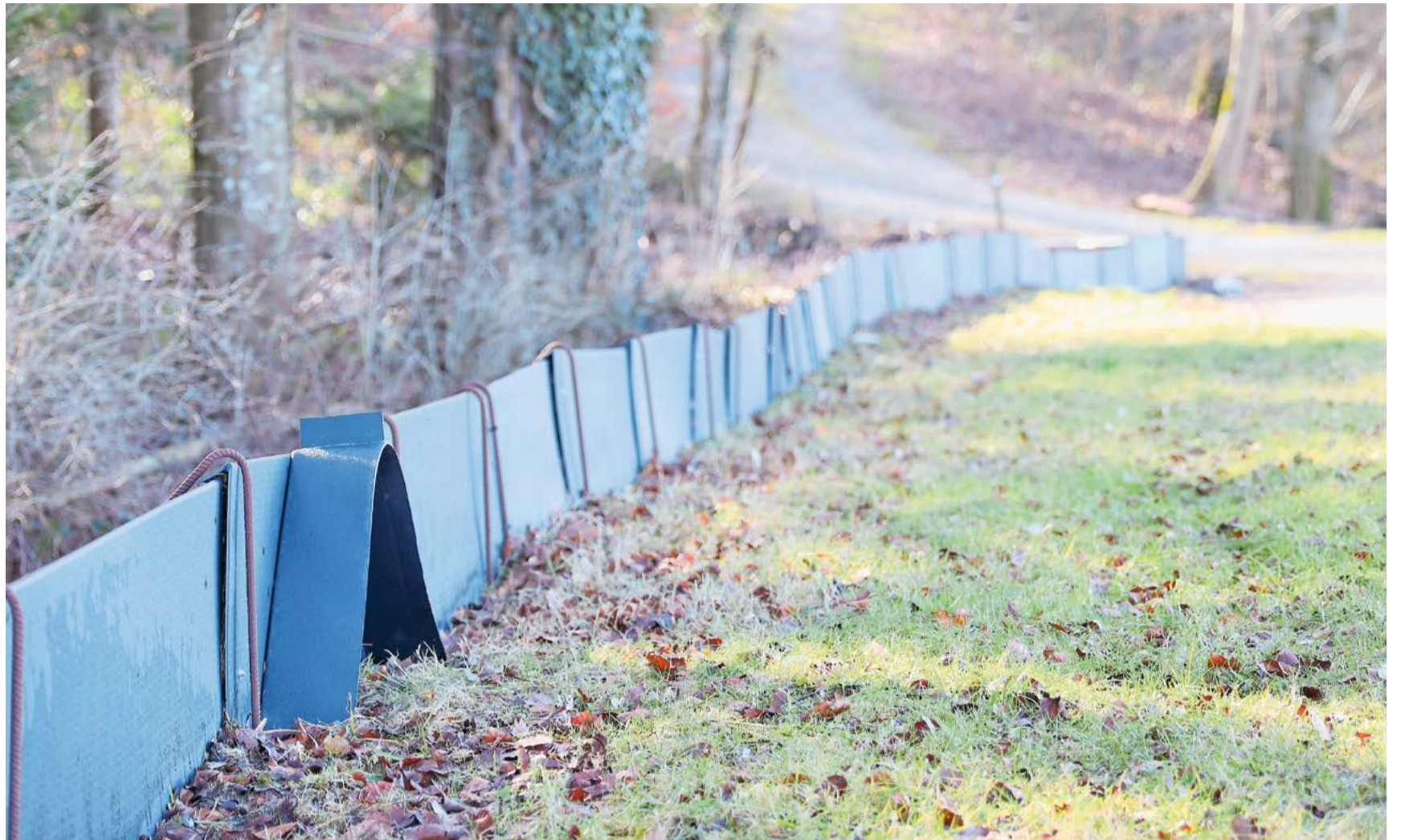
Im Rheinauer Bergholz ist der lange Sperrbereich dem ganzen Waldrand entlang bis zu den Zieltafeln der Schiessanlage mit Deltatec-Platten ausgeführt – neu kommen als Test alle 25 Meter Rampen hinzu, damit Amphibien nach dem Laichen wieder retour in den Wald finden.
