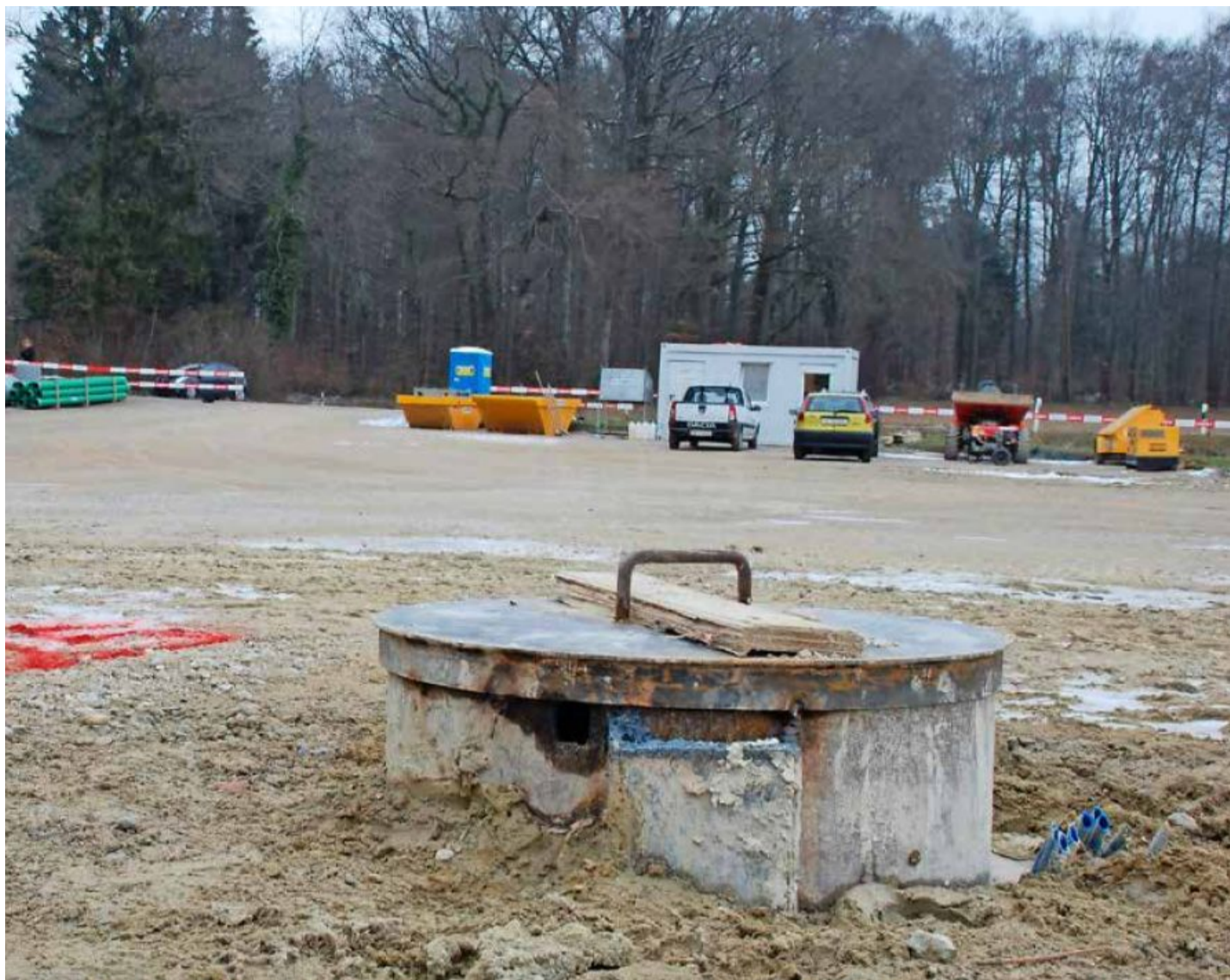
Die Vorbereitungen für die Tiefenbohrungen in Trüllikon im Weinland laufen.
